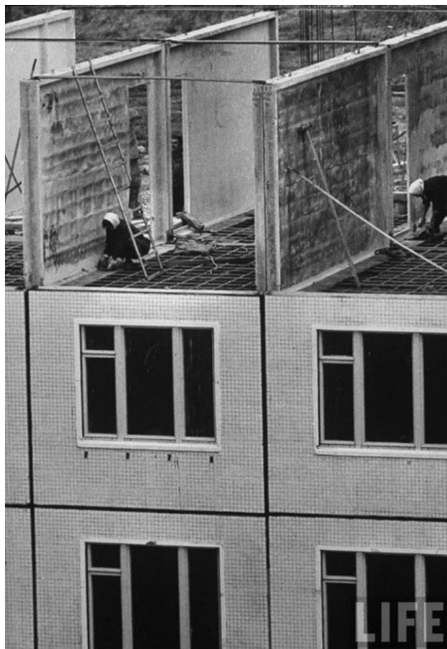
Спорудження хрущовки. Фото з відкритих джерел
