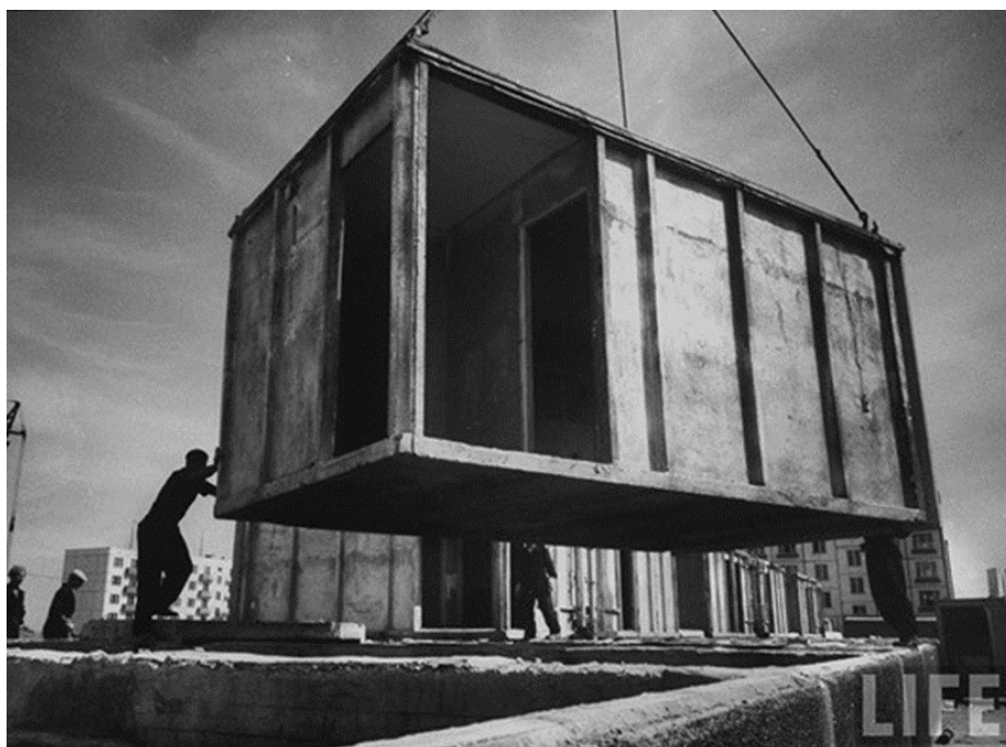
Спорудження хрущовки. Фото з відкритих джерел
