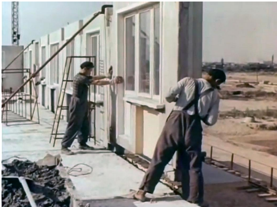
Спорудження хрущовки. Фото з відкритих джерел
