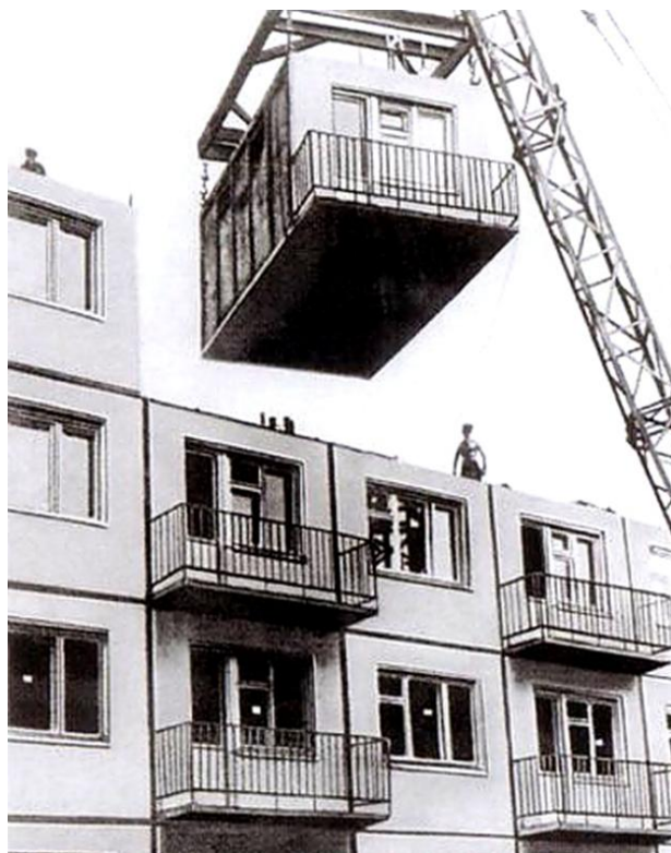
Спорудження хрущовки. Фото з відкритих джерел
